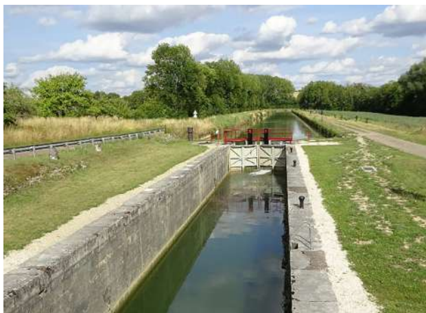
L'écluse de Commissey dans le Tonnerrois
